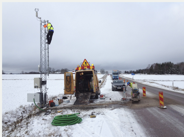
Figur 4. Installation av BIRDS system för fryspunktmätning vid station Simtuna.
